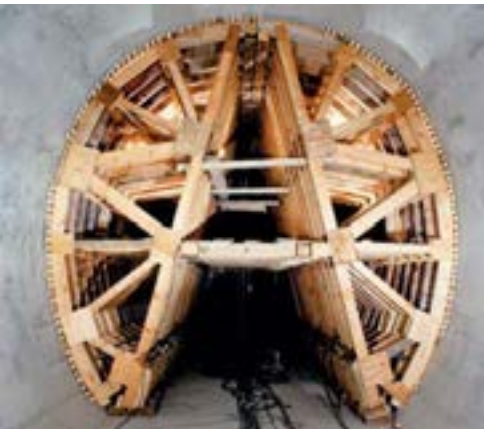
Tunnelschalung U-Bahn Lehel, München
