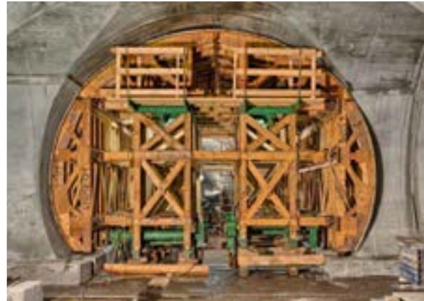
Tunnelschalung Bleßberg, ICE-Srecke Nürnberg - Erfurth
