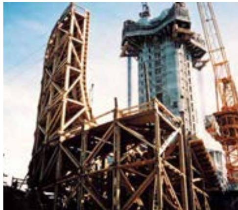
Sonderschalung Lehrgerüst und Schalung für BMW Museum, München
