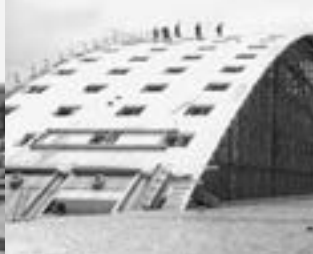
Schalung für Postpakethalle München
