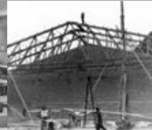
Bindermontage mit von Hand betriebener Seilwinde
