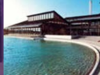
Fenster für das „Badria“ in Wasserburg
