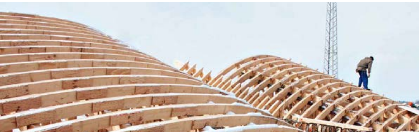
Tunnelschalung Portalgewölbe, Tunnel Aubing – A99
