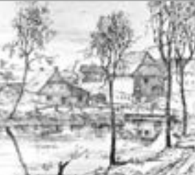
1923 Firmengebäude im ursprünglichen Zustand
