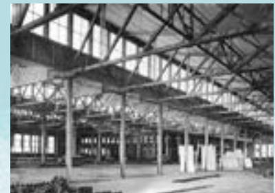
Bau von Hallen und Dachkonstruktionen für US-Kasernen in der Rheinland-Pfalz
