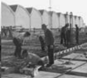
Deckenschalung Autounion Ingolstadt
